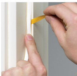
Tätningslistmontering
